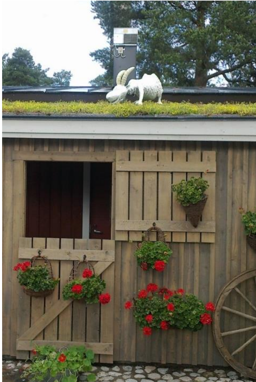
Kuva 5.3 Särkänniemessä sijaitseva viherkatto (kuva Ramboll-arkisto).
