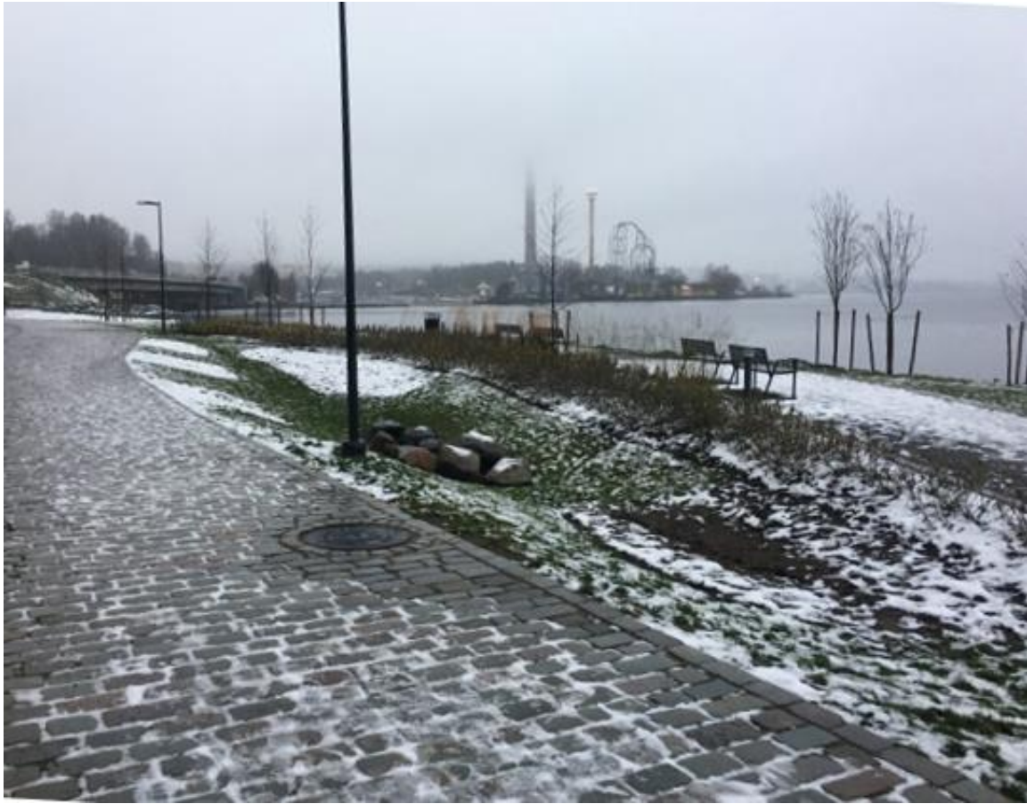
Kuva 5.8. Suunnittelualueen koillisnurkkauksessa sijaitsevaan Ranta-Tampellan puistoon on toteutettu painanne, joka toimii alueen hulevesiä käsittelevänä rakenteena.
